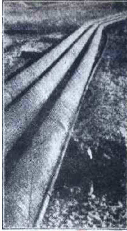
Çölde bir pipe - line Tehlikede
